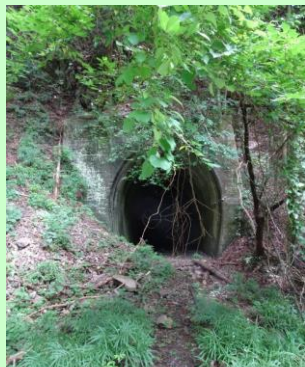
P-6 第二桃ケ澤トンネル
