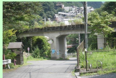
P-2 日原川橋梁の氷川側橋脚
