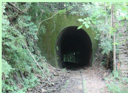
P-5 第三氷川トンネル水根口
