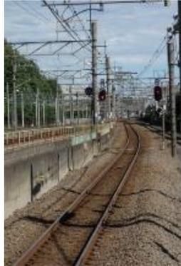
武蔵野線は府中本町側の武蔵野台地(府中市街地)をトンネルで抜けるために、旧下河原線の時代と比べると路盤が掘り下げられていて、当時との高低差があります(同様に、右上写真)。現在の北府中駅自体も、旧下河原線の時代と比べると路盤が掘り下げられており、北府中駅ホームからも高低差を確認できます。
