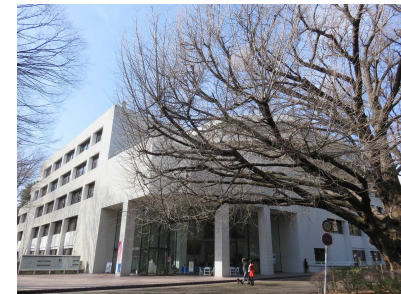
東京都立中央図書館 外観
