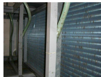
地下書庫 熱交換コイル 殺菌灯設置前
