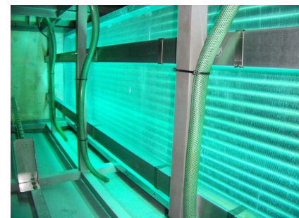
地下書庫 熱交換コイル 殺菌灯設置後
