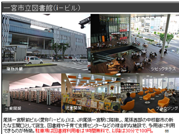
図22 一宮市立図書館（i-ビル）
